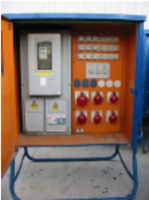
Baustromverteiler
